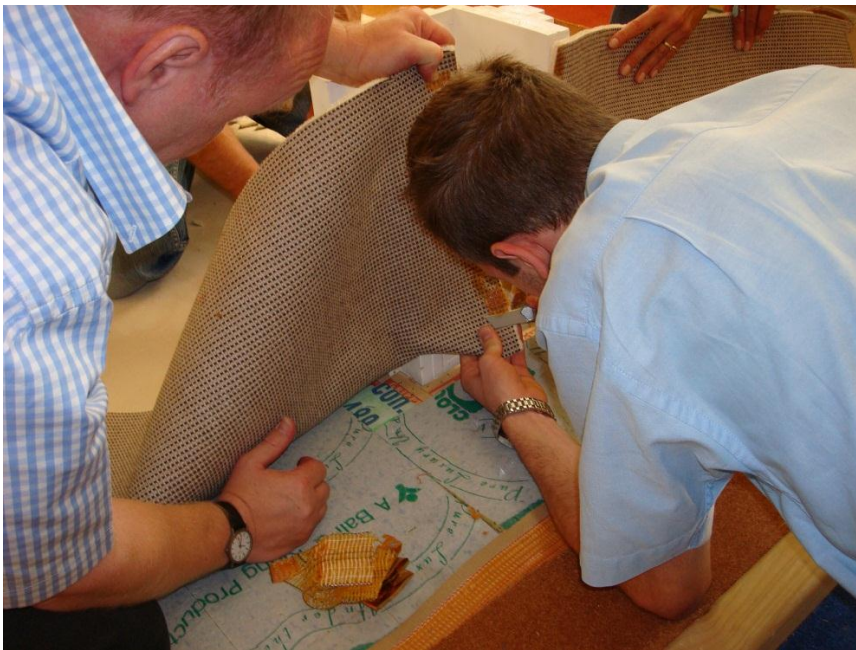
(Hier werden Kleberreste einer konfektionierten Naht entfernt)
